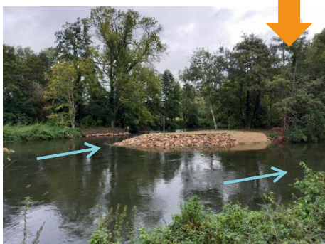
©SBV4R – septembre 2024 – 1 mois après travaux
