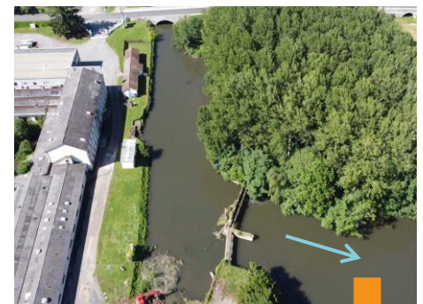
©Océlian - juin 2024 - avant travaux
