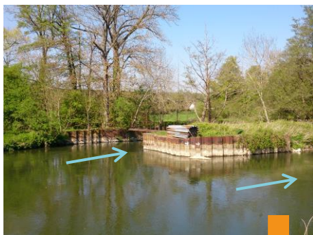
©SIRE1 – avril 2014 - avant travaux
