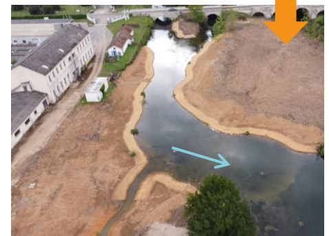
©Océlian - septembre 2024 – 1 mois après travaux
