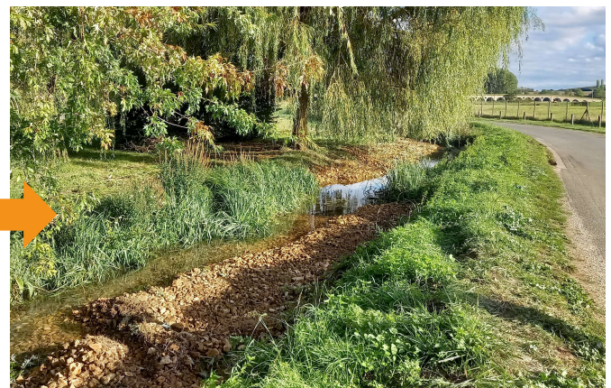
©SBV4R – septembre 2023, 1 jour après travaux
